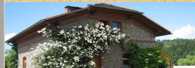
Künstlerwerkstatt im alten Bahnhof in Fischhaus
