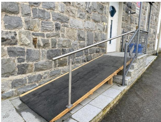
Rampe Pfarrheim Oberdiendorf
